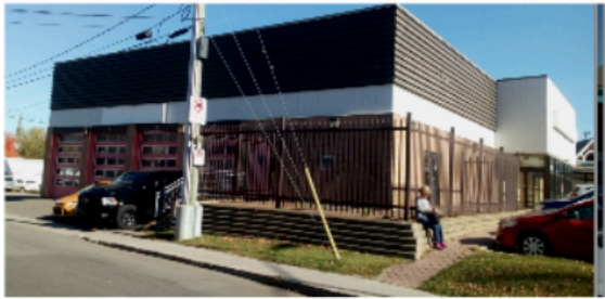
VUE DU GARAGE , RUE SAINT-PIERRE S (V2)
